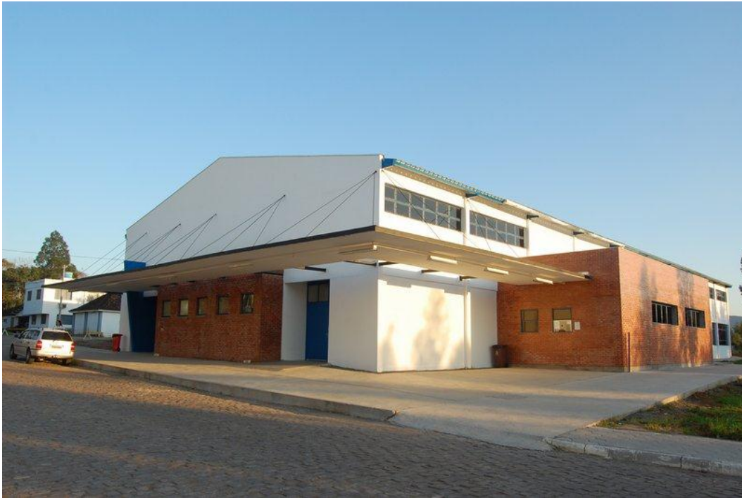
Figura 7 – Fachada do RU Campus II
